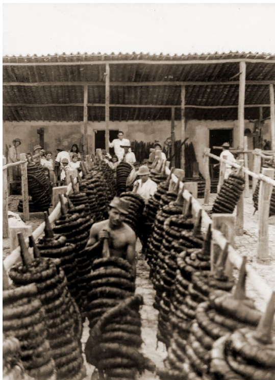
Figura 13 - Fábrica de fumo em Arapiraca.
