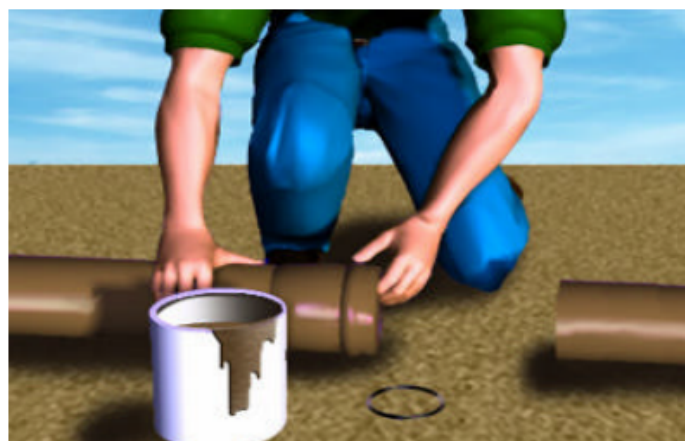
Figura 3 – Aplicação de pasta lubrificante (A pasta lubrificante será aplicada sobre o anel já posicionado e sobre a ponta do tubo a ser conectada. Não deverão ser utilizados óleos e graxa, pois poderão danificar o anel de borracha)
