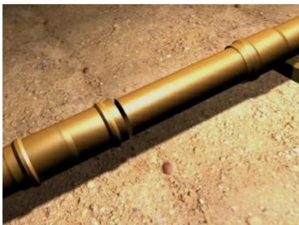
Figura 13 – O pedaço de tubo será conectado à bolsa a jusante
