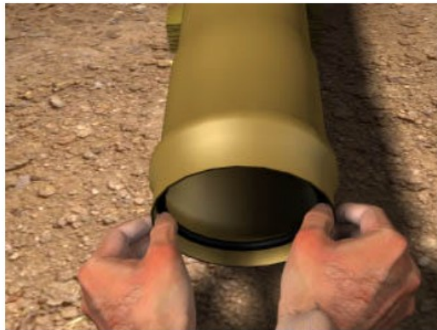
Figura 2 – Introdução do anel de Borracha (O anel de borracha será introduzido no sulco da bolsa)
