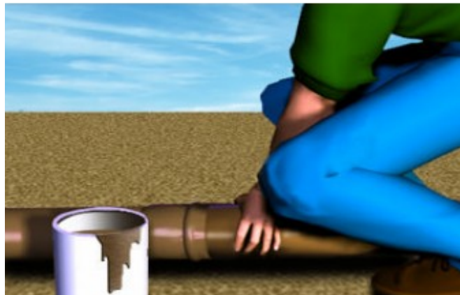
Figura 4 – Conexões dos tubos (A ponta do tubo (tubo macho) será introduzido até o fundo da bolsa do outro tubo.
