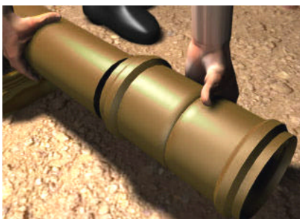
Figura 11 – Montagem de luva de correr (A ponta do tubo, já lubrificada, receberá a luva de correr)
