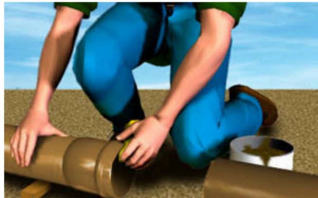
Figura 1 – Limpeza (Primeiramente serão limpas a bolsa e a ponta a serem conectadas)
