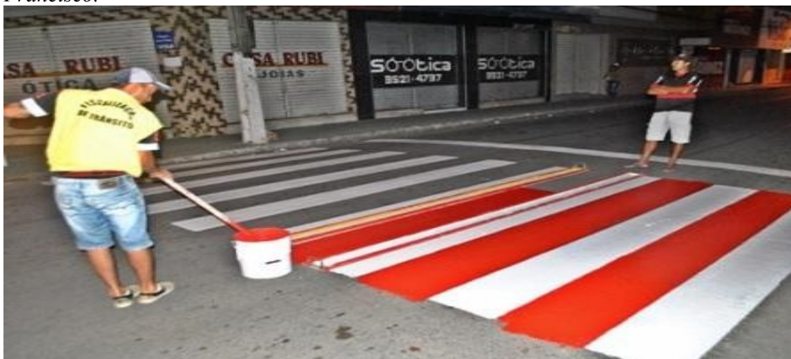
Figura 9. Execução da pintura da faixa de pedestre e canalização na Av. Rio Branco.
